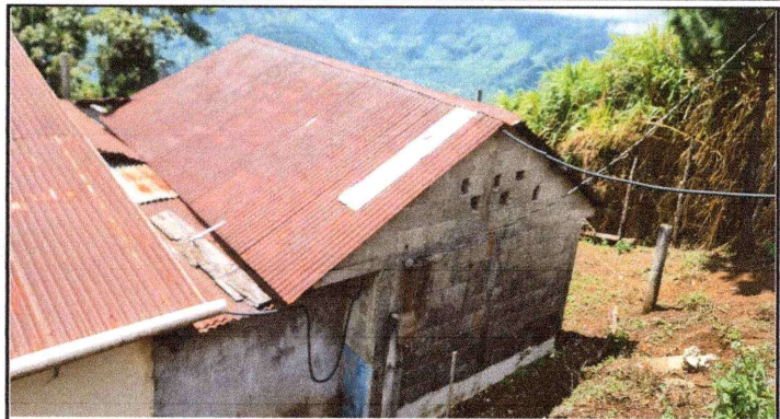
Foto 1: Sustitución de lámina acanalada en mal estado por lámina troquelada.
