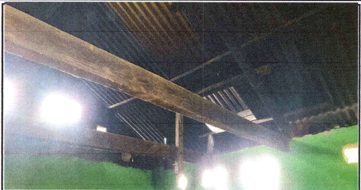
Foto 2: Sustitución de estructura de madera por metal para mayor vida útil.
