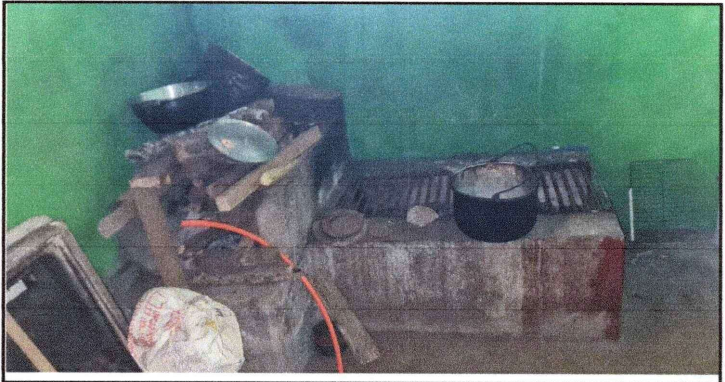
Foto 4: Mejoramiento y sustitución de polleton en mal estado por polleton nuevo e instalación de parrillas de metal.
