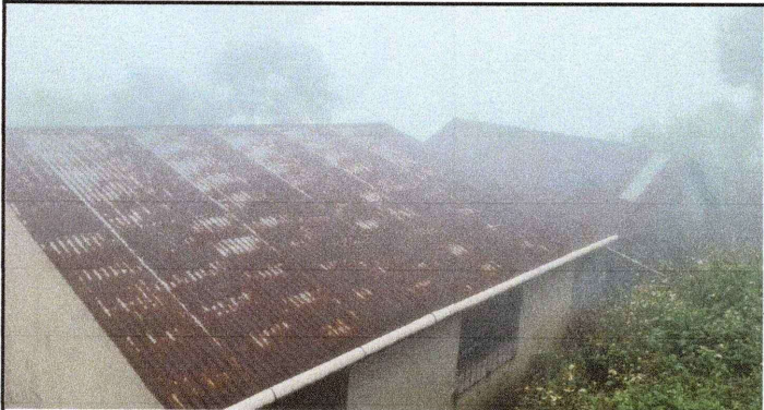
Foto 7: Sustrucción de lámina acanalada en mal estado por lámina troquelada para mejorar la calidad de los ambientes (aulas).
