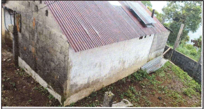
Foto 3: Repello de paredes exteriores de cocina para mejorar condiciones de humedad.
